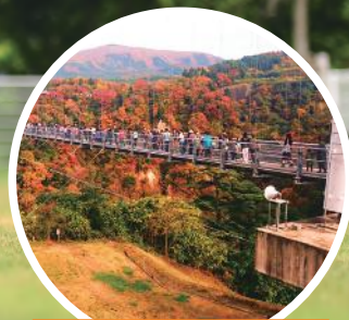
九重“夢”大吊橋
