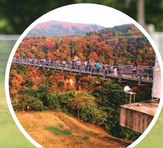
九重“夢”大吊橋
