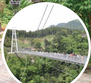
九重「夢」大吊橋
